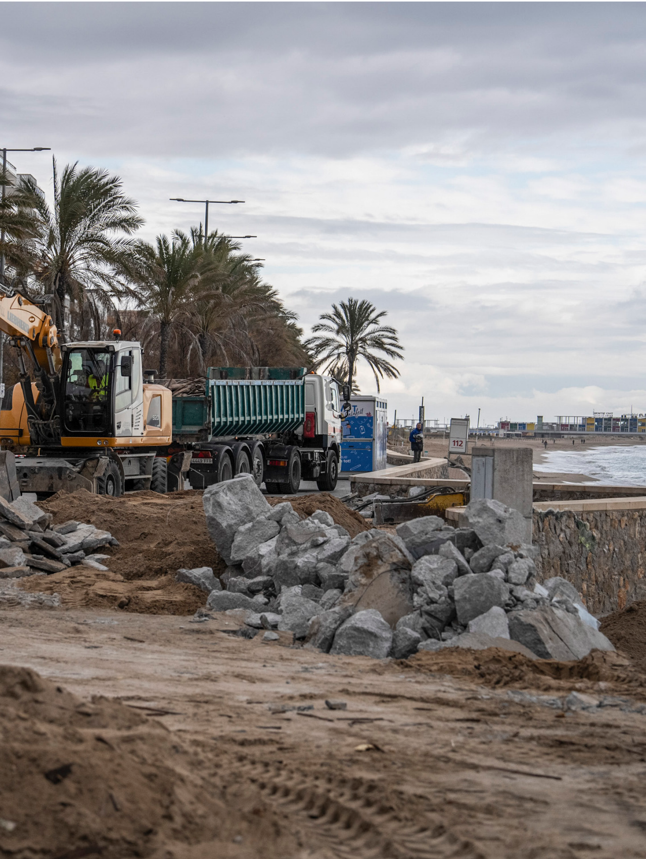
El temporal Harry va causar danys estructurals greus i va obligar el Ministeri per a la Transició Ecològica a destinar 1,4 milions d'euros el març del 2026 a reparacions d'emergència a l'Illa de Buda i Calafell, on l'onatge va descalçar el mur del passeig de Mas Mel. © Zowly voeten
