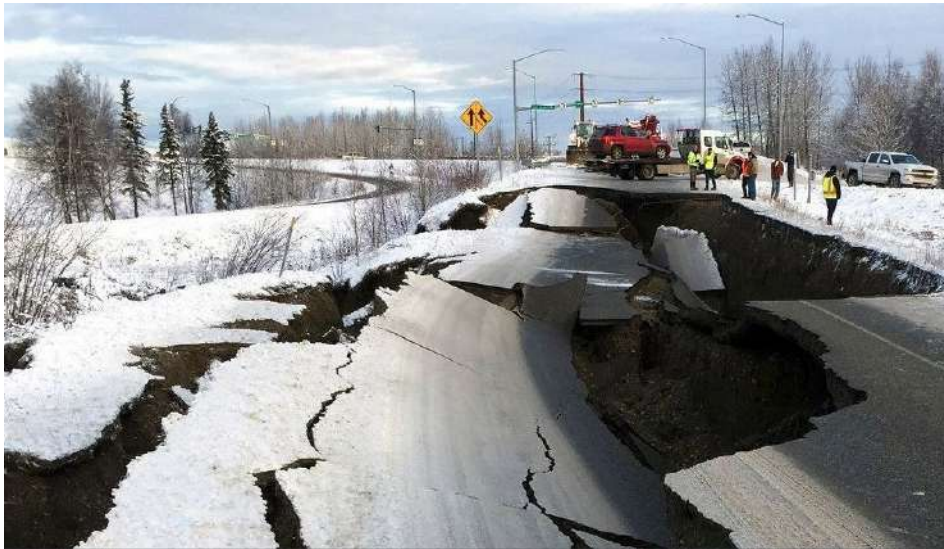
Figura 15: Colapso de una carretera en Alaska (EEUU) por el derretimiento del permafrost.
