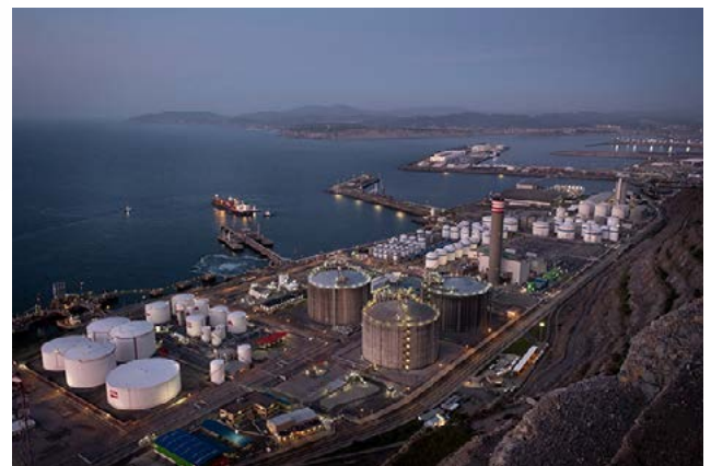
La planta de regasificación de Bahía de Bizkaia Gas (BBG). Cuenta con tres tanques y está participada por Enagás (50%) y el Ente Vasco de Energía, EVE (50%).
