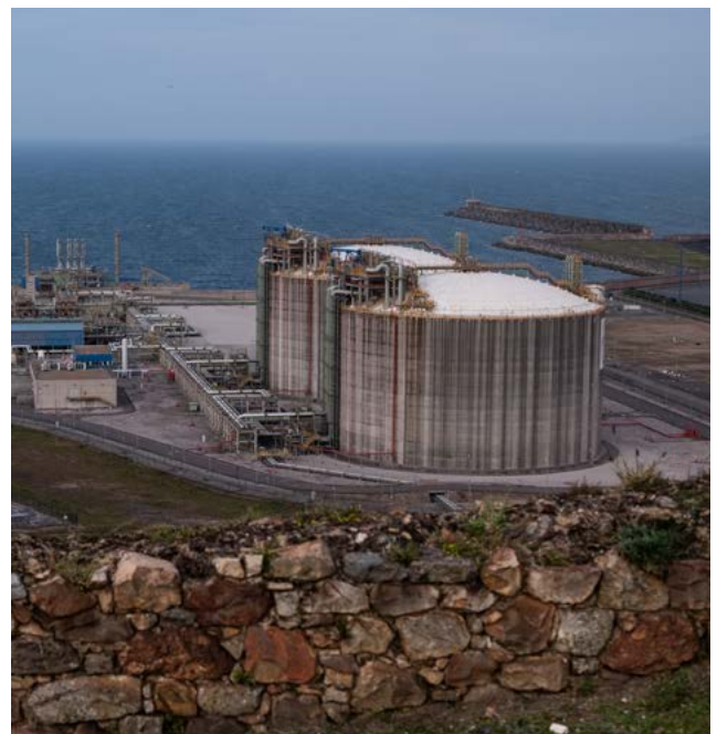
En la imagen la planta de regasificación de Enagás, en el Musel dispone de una capacidad de almacenamiento de 300.000 m 3 de GNL. © Greenpeace / Pedro Armestre
