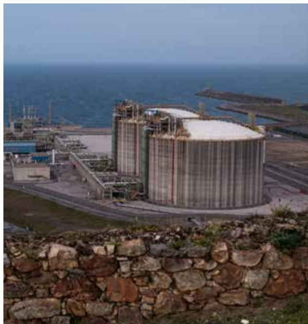
En la imagen la planta de regasificación de Enagás, en el Musel dispone de una capacidad de almacenamiento de 300.000 m 3 de GNL. © Greenpeace / Pedro Armestre
