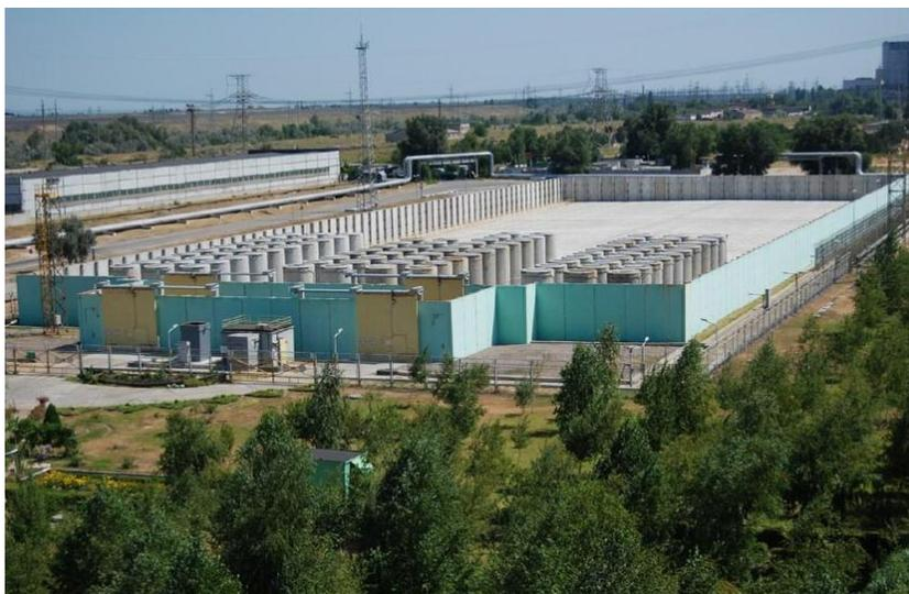
**Instalación de almacenamiento en seco (DSFSF) en el sitio de Zaporizhzhia con contenedores de hormigón para almacenamiento en seco**
