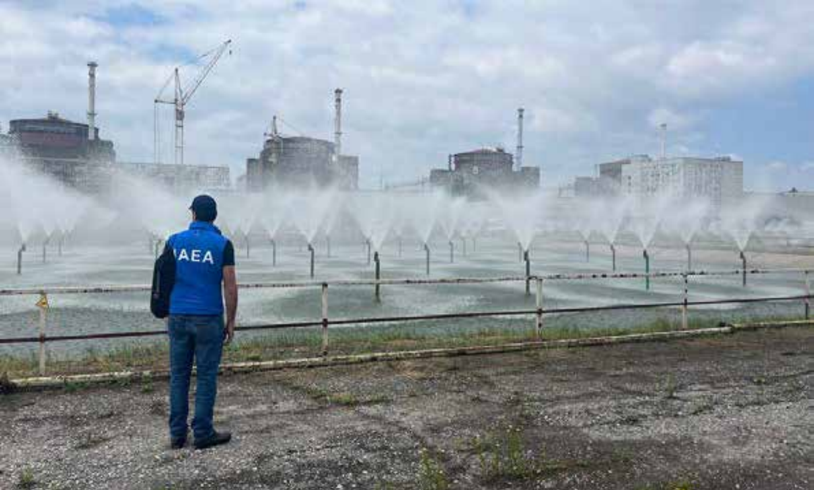
Estanque de refrigeración por pulverización, central nuclear de Zaporíyia, 15 de junio 2023. © Fredrik Dahl / IAEA
