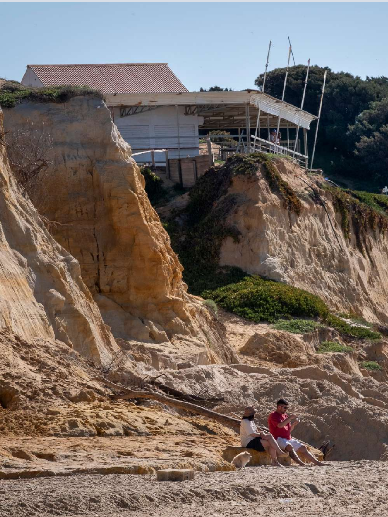
Matalascañas, Huelva. Edificación dañada vista desde la playa tras el paso de la borrasca Harry. © Pedro Armestre/ Greenpeace
