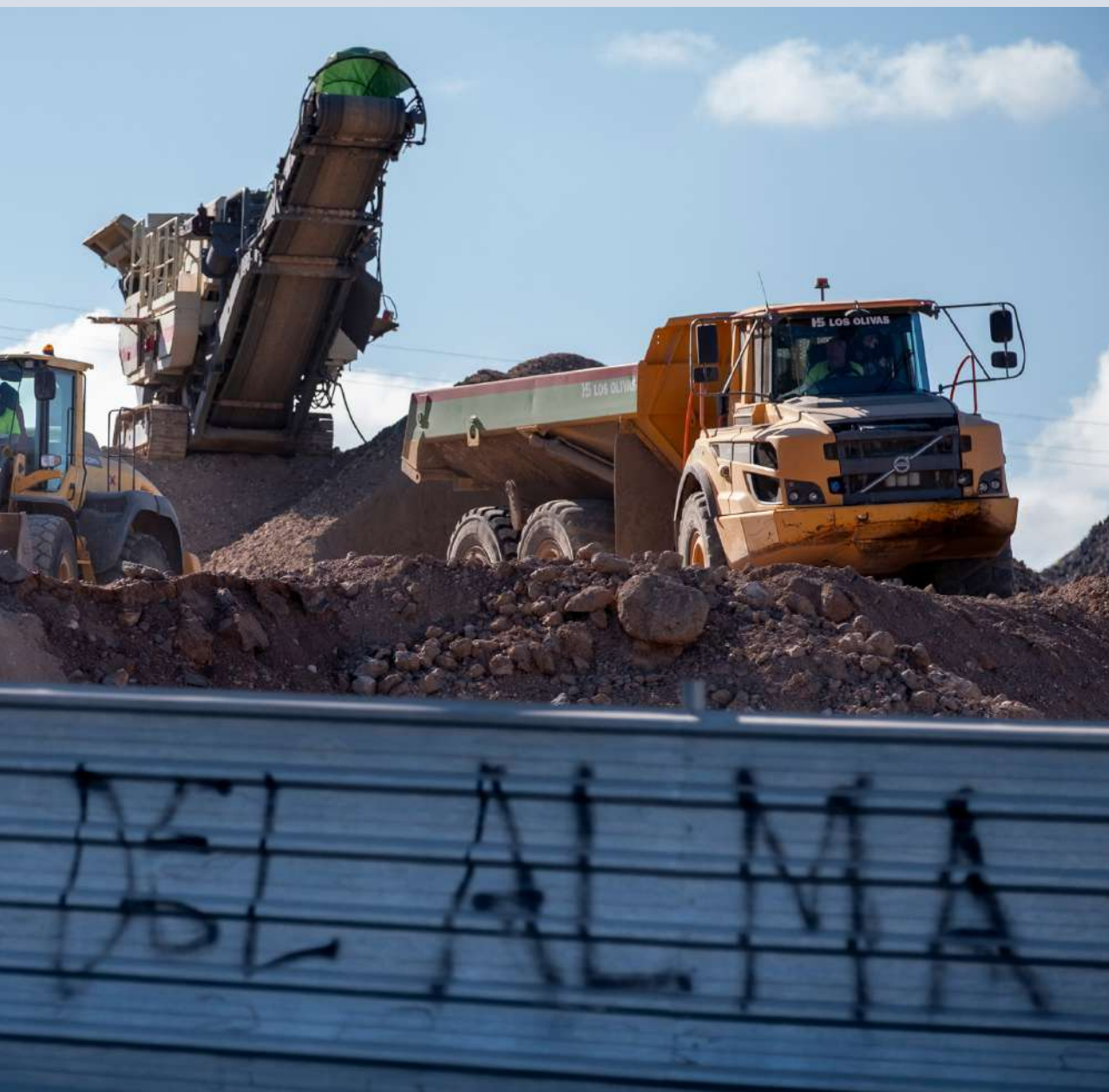
Obras del proyecto Cuna del Alma en El Puertito de Adeje, Tenerife. La justicia investiga delitos contra la ordenación del territorio y el medioambiente por la autorización dada al proyecto para ocupar la franja de servidumbre de protección de la costa (100 metros) gracias al permiso concedido por la Dirección General de Costas de Canarias. © Pedro Armestre / Greenpeace
