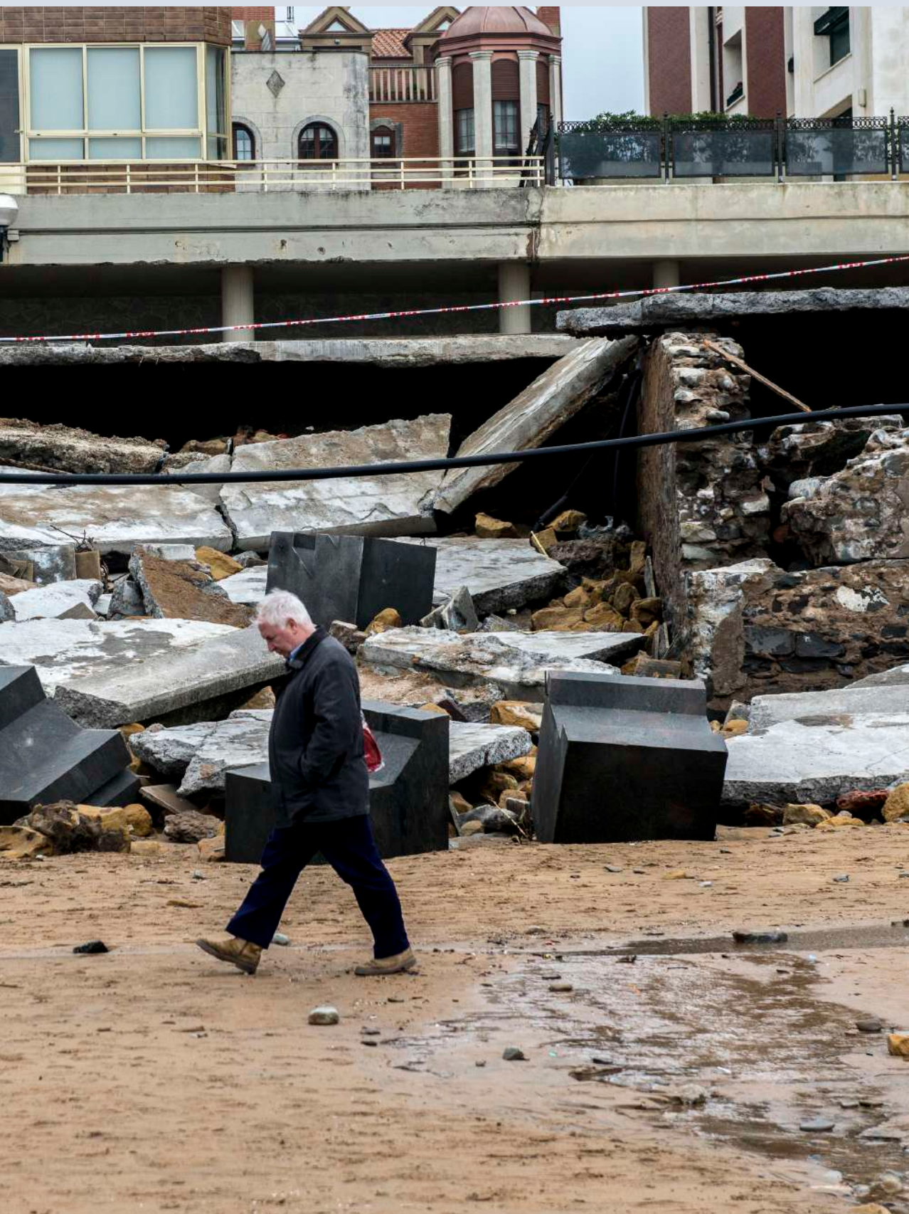
Daños en el malecón de Zarautz tras el paso de la borrasca Christine. Es uno de los paseos costeros con mayor nivel de riesgo estructural ya que bloquea la dinámica de sedimentación natural, provocando la pérdida sistemática de arena y aumentando el impacto de los temporales en el casco urbano.
