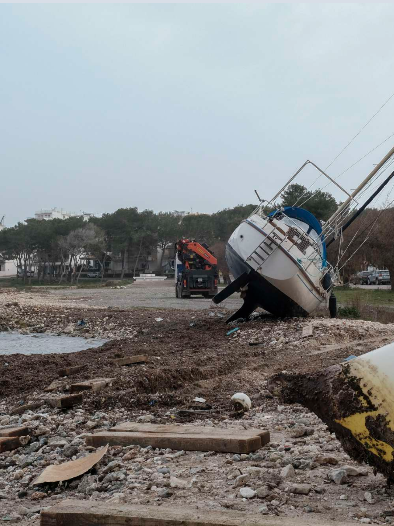
Daños provocados en la zona costera de Alcanada, Puerto de Alcúdia (Mallorca) tras el paso de la borrasca Gloria en 2020. © Isaac Buj
