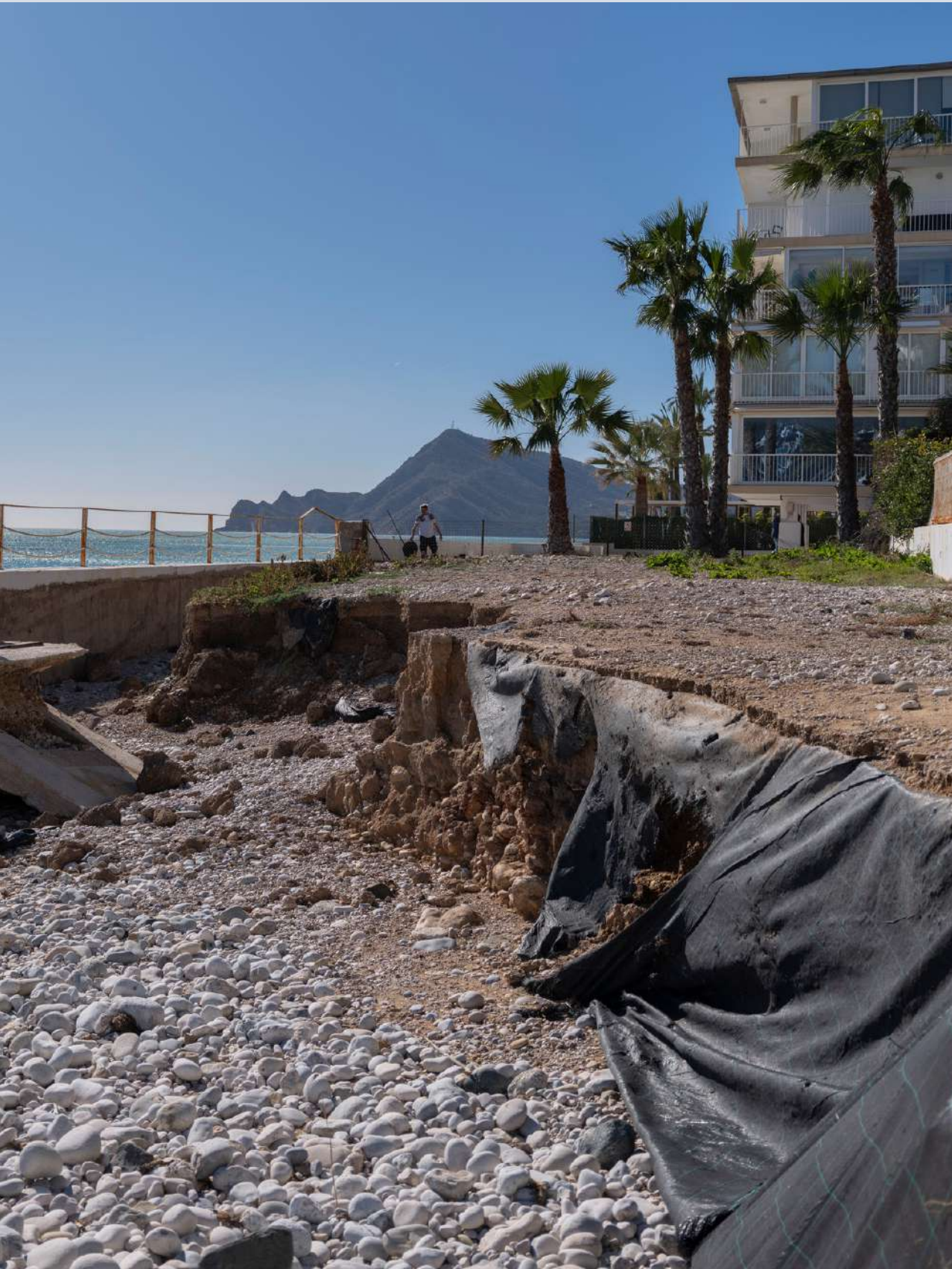
Daños en la playa de Cap Negret en Altea provocados por la borrasca Harry. © Pedro Armestre/ Greenpeace
